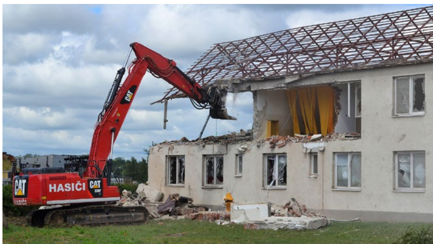
Zdravotní středisko bylo první úplně demolovanou budovou v obci Lužice
