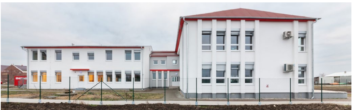
Opravená škola v obci Hrušky, nahoře stav po tornádu
