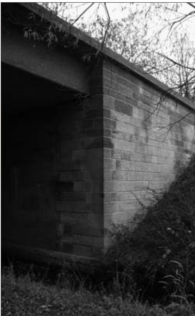
➤ Detail provedení opěry, nosné desky a římsy (2003)
