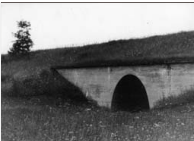
➤ Most přes potok Výpustek u obce Voděrady (1962)
