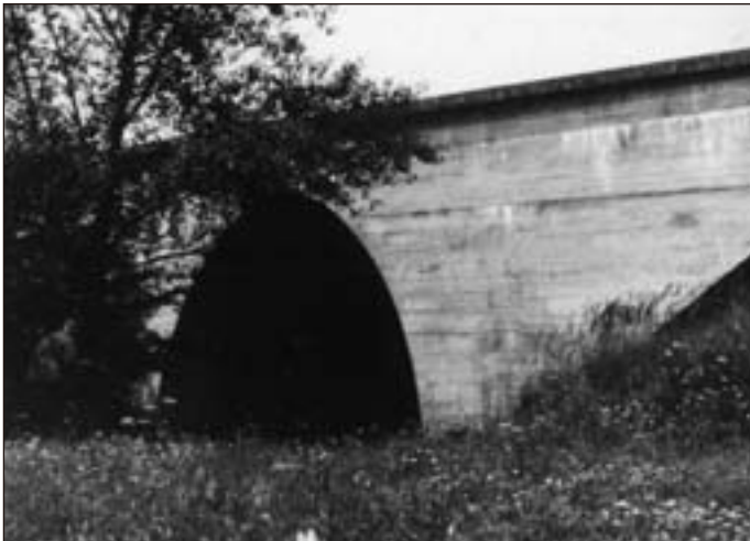
➤ Dálniční most přes potok Úmoří u Drnovic (1962)
