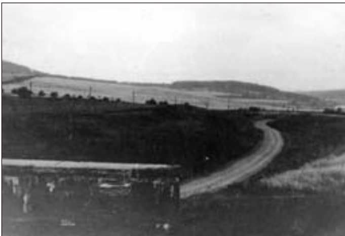
Dálňní most přes nedokončené přeložky železnice Chornice – Velké Opatovice – Skalice nad Svitavou a silnice Velké Opatovice – Cetkovice (1962)
