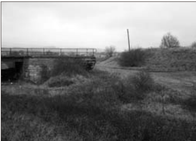
➤ Dálniční most u obce Svitávka: Stejně místo po čtyřiceti letech. Přeložka silnice již také není používána (2002).
