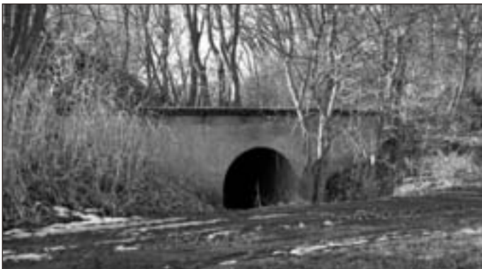
Dálniční most severovýchodně od Jevíčka (1999)
