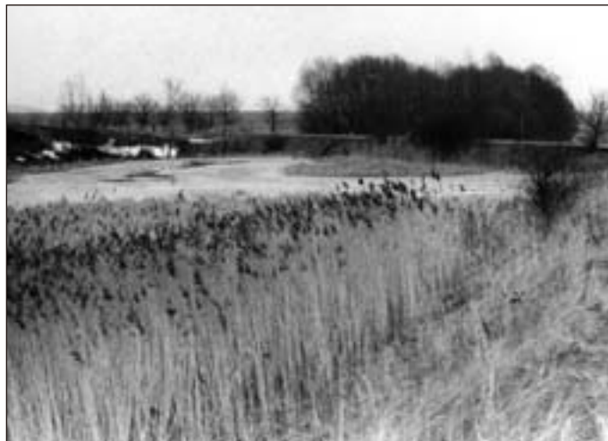
➤ Zatopené dálniční těleso v místech křížení s dnešní silnicí I/43 (1985)
