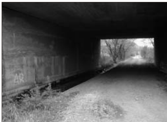
➤ Souběžné vedení potoka a polní cesty pod mostem (2003)
