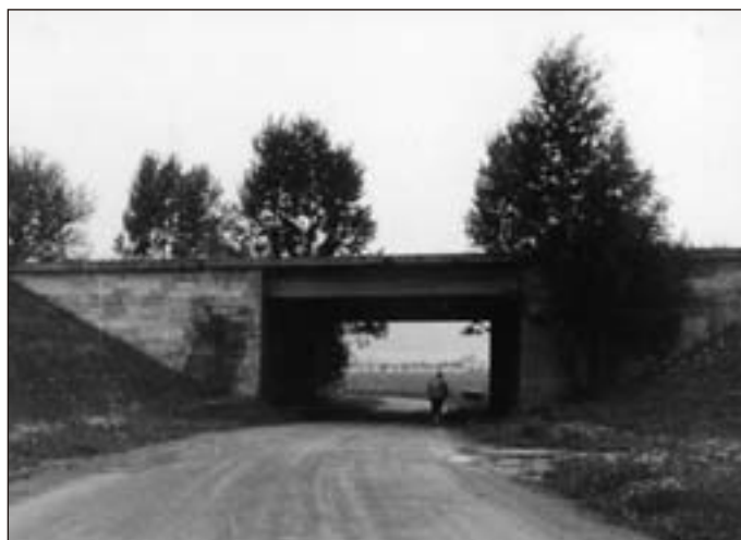
➤ Dálniční most přes silnici Skalice nad Svitavou – Drnovice (1962)
