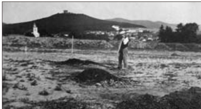
Započaté zemní práce (skrývka ornice) na severním předmostí plánovaného mostu přes údolí potoka Pacovka v Městečku Trnávce v r. 1941
