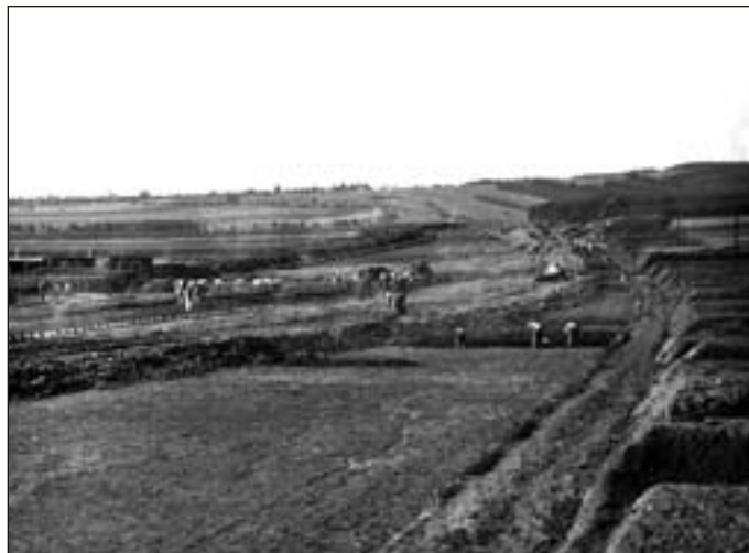
Stavba dálnice severně od Vísky u Jevíčka v r. 1939
