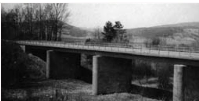
Most přes dálnici (1985)
