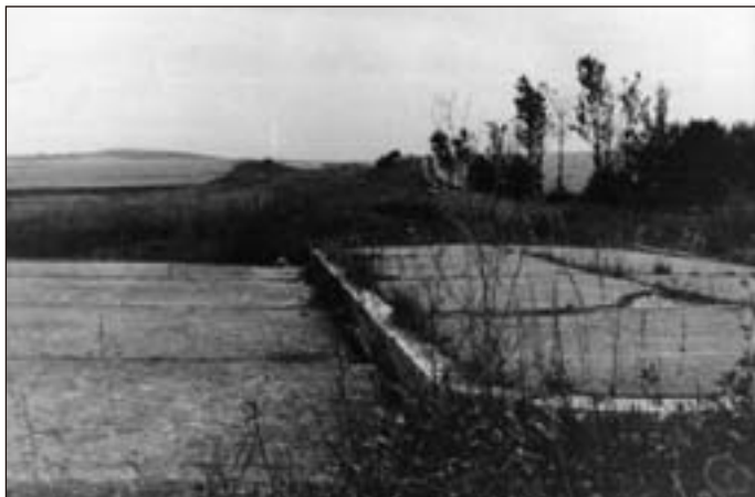
Provedení středního dělicího pásu na mostě (1962)
