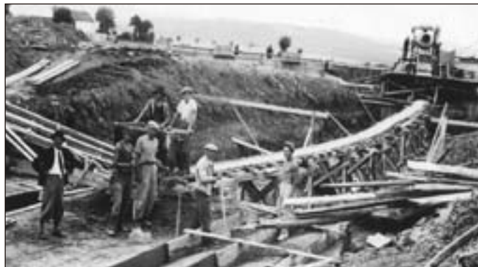
Stavba základů dálničního mostu u Jevíčka v r. 1939
