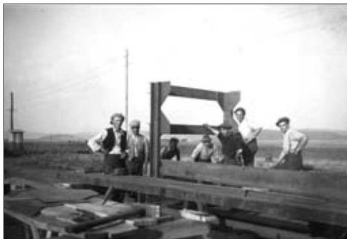
Na fotografii jsou zachyceni dělníci na stavbě dálnice. Dále na fotografii zřetelně vidíme telefonní vedení, které umožňovalo neustále spojení podél celého rozestavěného úseku dálnice v r. 1940.
