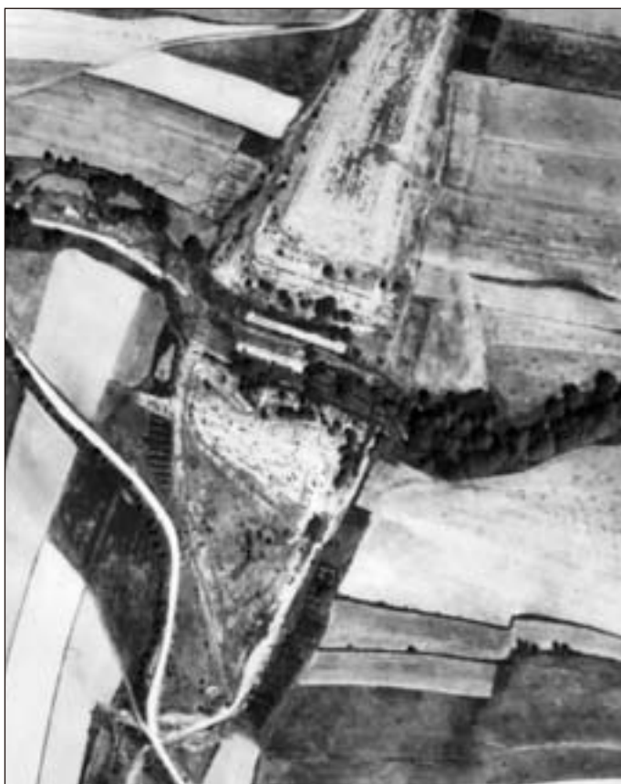
Zemní práce a základy mostu v údolí Arnoštovského potoka nedaleko Vísky u Jevíčka (1950)
