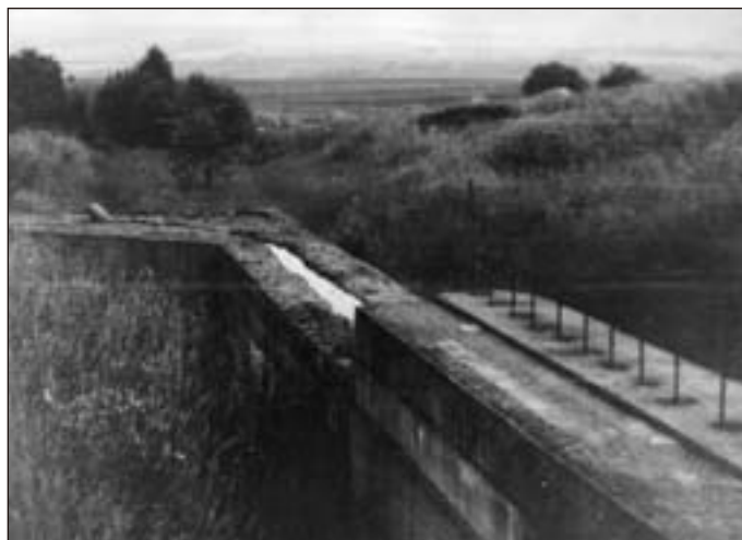
➤ Nedokončený most u Borotína (1962)
