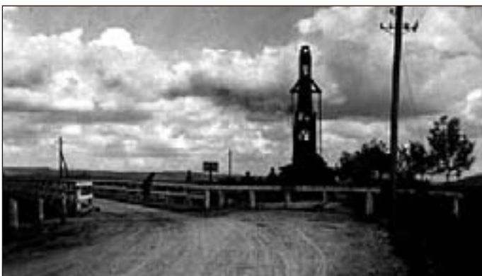
Pro zachování dopravy na silnici Bořítov – Lysice byl přes zářez dálnice vybudován provizorní dřevěný most (foto z r. 1941). V padesátých letech byl provizorní most zbořen. Přes zářez dálnice byl proveden násyp, na který byla přeložena silnice z Bořítova do Lysic. Na fotografii vidíme provizorní dřevěný most. V zářezu dálnice za mostem stojí parní rypadlo.
