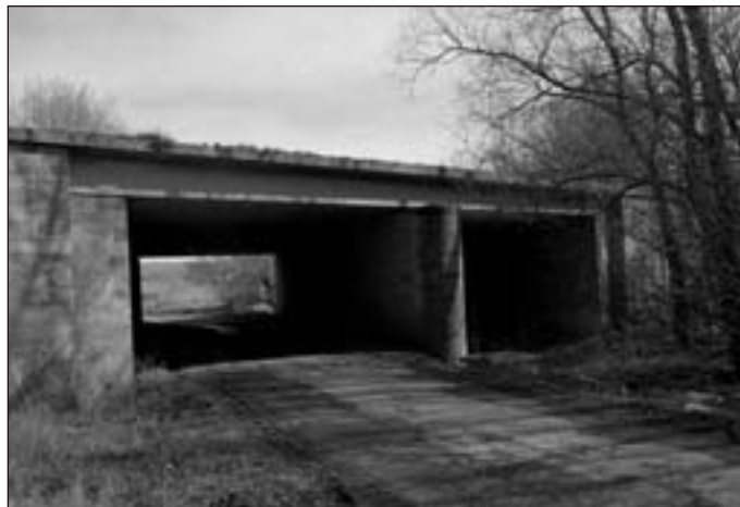
Dálňní most přes nedokončené přeložky železnice Chornice – Velké Opatovice – Skalice nad Svitavou a silnice Velké Opatovice – Cetkovice (1999)
