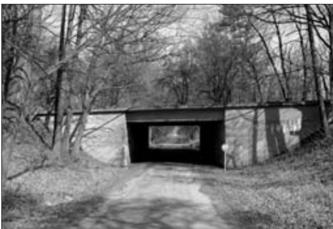
Dálňní most přes silnice Borotín – Cetkovice (2002)
