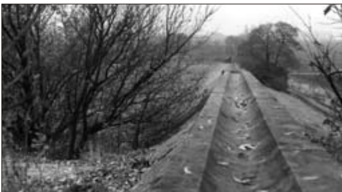
Jevíčko: most přes zrušený mlýnský náhon (detail odvodnění římsy mostu, 1986)
