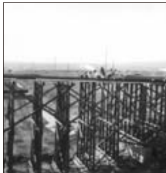
Provizorní dřevěný most pro převedení dopravy v době výstavby definitivního mostu v r. 1940
