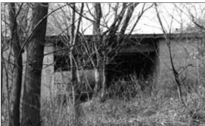
Dálniční most přes polní cestu u Jevíčka: Jedná se o první dokončený dálniční most na trase dálnice od severu. Okolí mostu je velmi zarostlé vegetací, což ztěžuje fotodokumentaci (1986).
