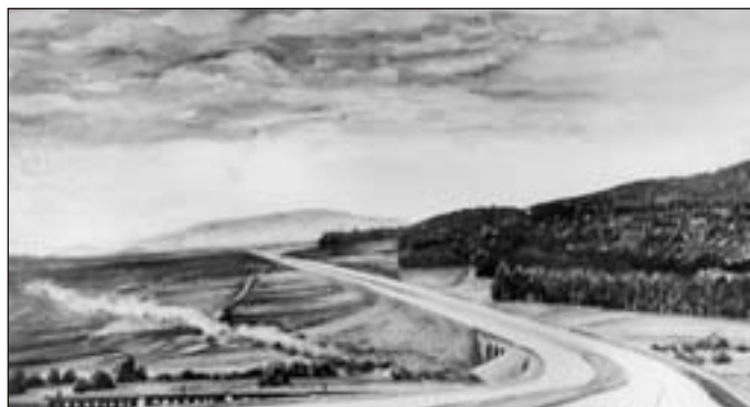
Přemostění říčky Moravská Sázava a železniční tratě Česká Třebová – Olomouc asi 200 metrů západně od nádraží Krasíkov. Dále pohled na dálnici ve směru na Vídeň. Za tímto přemostěním začínal stavební díl 28, který byl připraven k výstavbě. Stavební práce však nebyly zahájeny.
