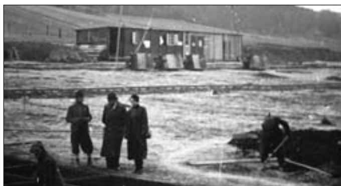
Stavba dálnice u obce Lazy na podzim 1939
