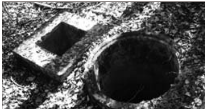
Detailní snímek dálniční kanalizace poblíž dálniční křižovatky Jevíčko (2002)
