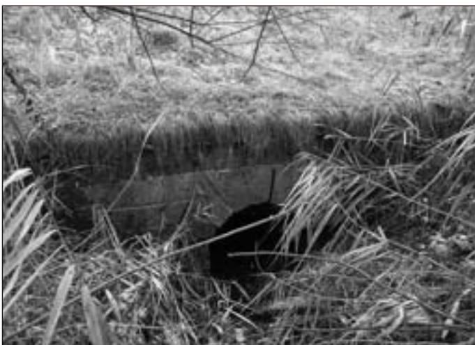
Propust u obce Svitávka (1999)
