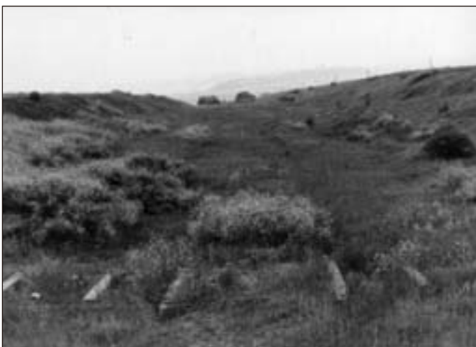
➤ Trasa dálnice u Voděrad: zářez dálnice a betonové patky provizorního dřevěného mostu (1962)
