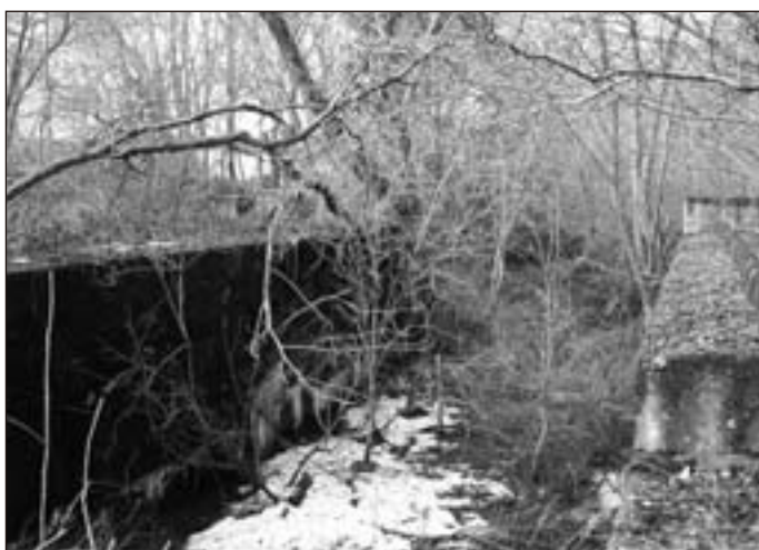
➤ Nedokončený most u Borotína (2005)
