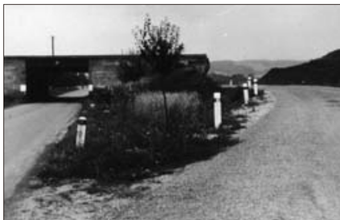
Dálniční most u obce Svitávka: Z důvodu malé volné výšky a šířky bylo koncem padesátých let vybudováno na fotografii zachycené objízdné provizorium. Most ještě nemá osazeno ocelové zábradlí (1962).
