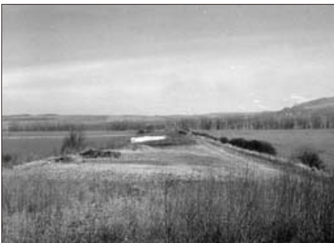
Těleso dálnice u Svitávky (1999)
