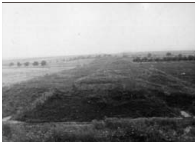
Základy dálničního mostu přes polní cestu a inundaci řeky Svitavy u Svitávky (1962)
