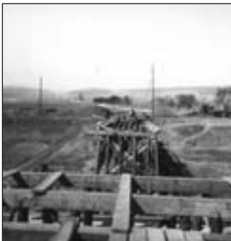
Provizorní dřevěný most pro převedení dopravy v době výstavby definitivního mostu v r. 1940
