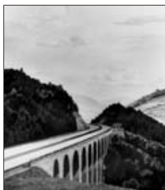
Linhartice: Dvě varianty dálničního mostu přes údolí Třebůvky v Linharticích. Konstrukce mostů měla být stejná. Rozdílné bylo pouze pojetí jižního předmostí. První varianta počítala pouze s malou odpočívkou, druhá varianta s velkým parkovištěm umožňujícím pohled na konstrukci mostu a výhled na Moravskou Třebovou. K realizaci byla nakonec zvolena druhá varianta.
