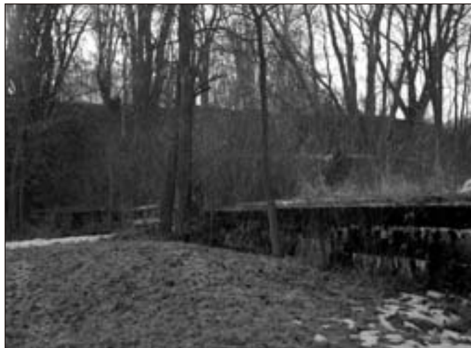
Základy nedokončeného mostu ve Vísce u Jevíčka (1999)
