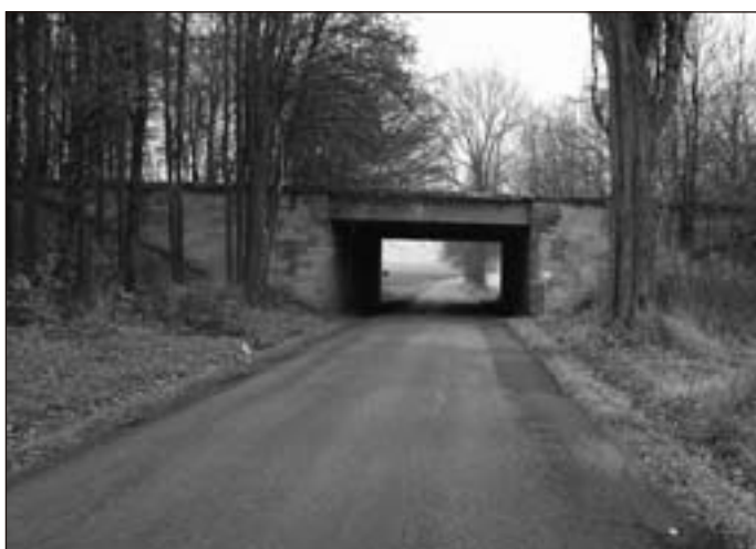
➤ Dálniční most přes silnici Vanovice – Šebetov (2004)
