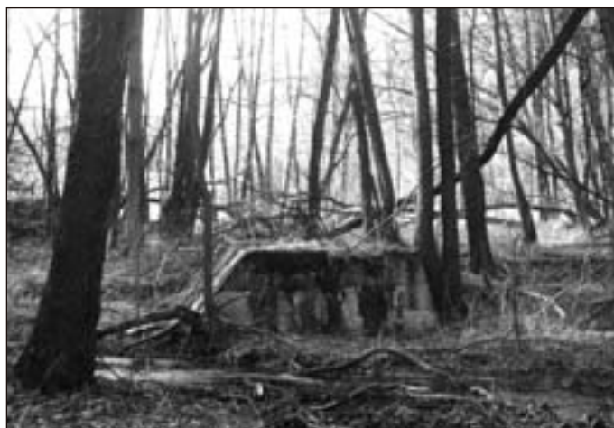
Základy dálničního mostu přes Arnoštovský potok (2002)
