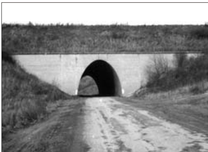
Dálniční most pro silnici Sudice – Vísky (1985)
