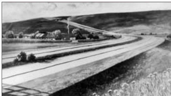
Bílá Studně: Pohled severním směrem. Dálnice obloukem míjí obec Bílá Studně a pokračuje ve směru na sever.
