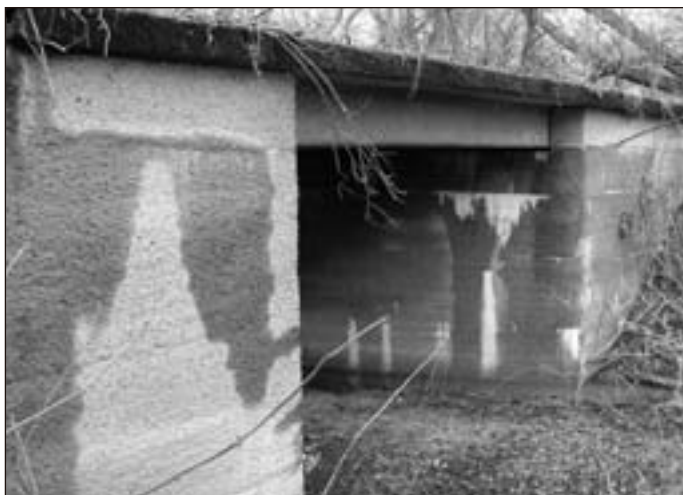
➤ Dálniční most přes zrušenou polní cestu u Borotína (2004)
