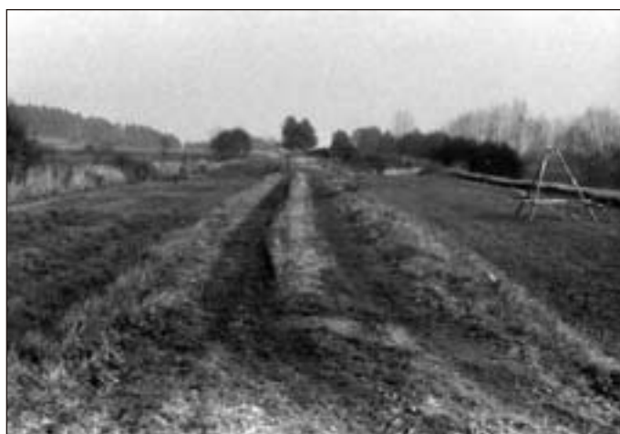
Opuštěné těleso dálnice u obce Chornice (1985)
