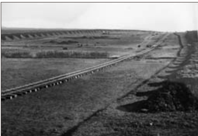
Staveniště dálnice u Borotína 6. 6. 1939
