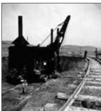
Parní rypadlo značky Orenstein & Koppel typ 16 firmy Lanna a. s. při práci na stavbě dálnice
