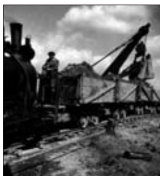
Parní rypadlo značky Orenstein & Koppel typ 16 firmy Lanna a. s. při práci na stavbě dálnice
