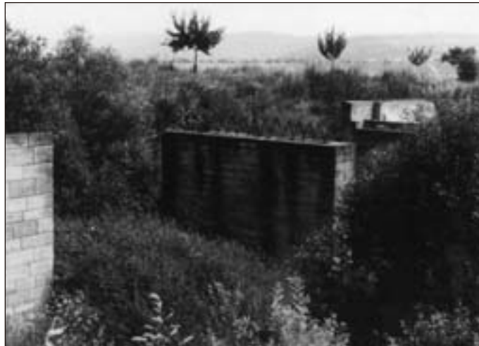
➤ Nedokončený most přes dálnici u obce Lysice (1962)
