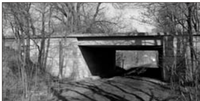
Dálniční most přes polní cestu a zrušený mlýnský náhon u Velkých Opatovic (1999)
