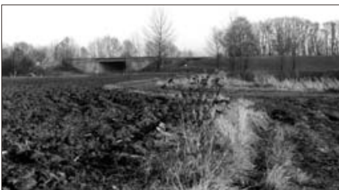
Dálniční most přes silnici Jevíčko – Křenov (1986)
