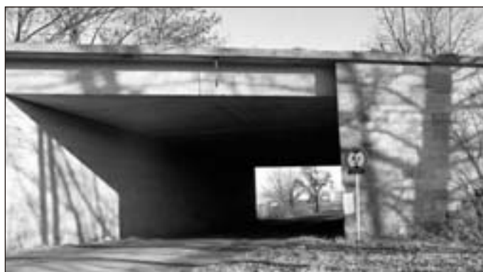
Dálniční most přes silnici Jevíčko – Křenov (1999)
