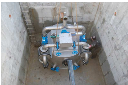
Obr. Suchá čerpací stanice – montáž
