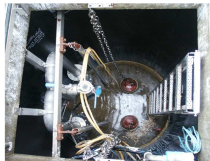
Obr. Klasická čerpací stanice s ponořenými čerpadly
