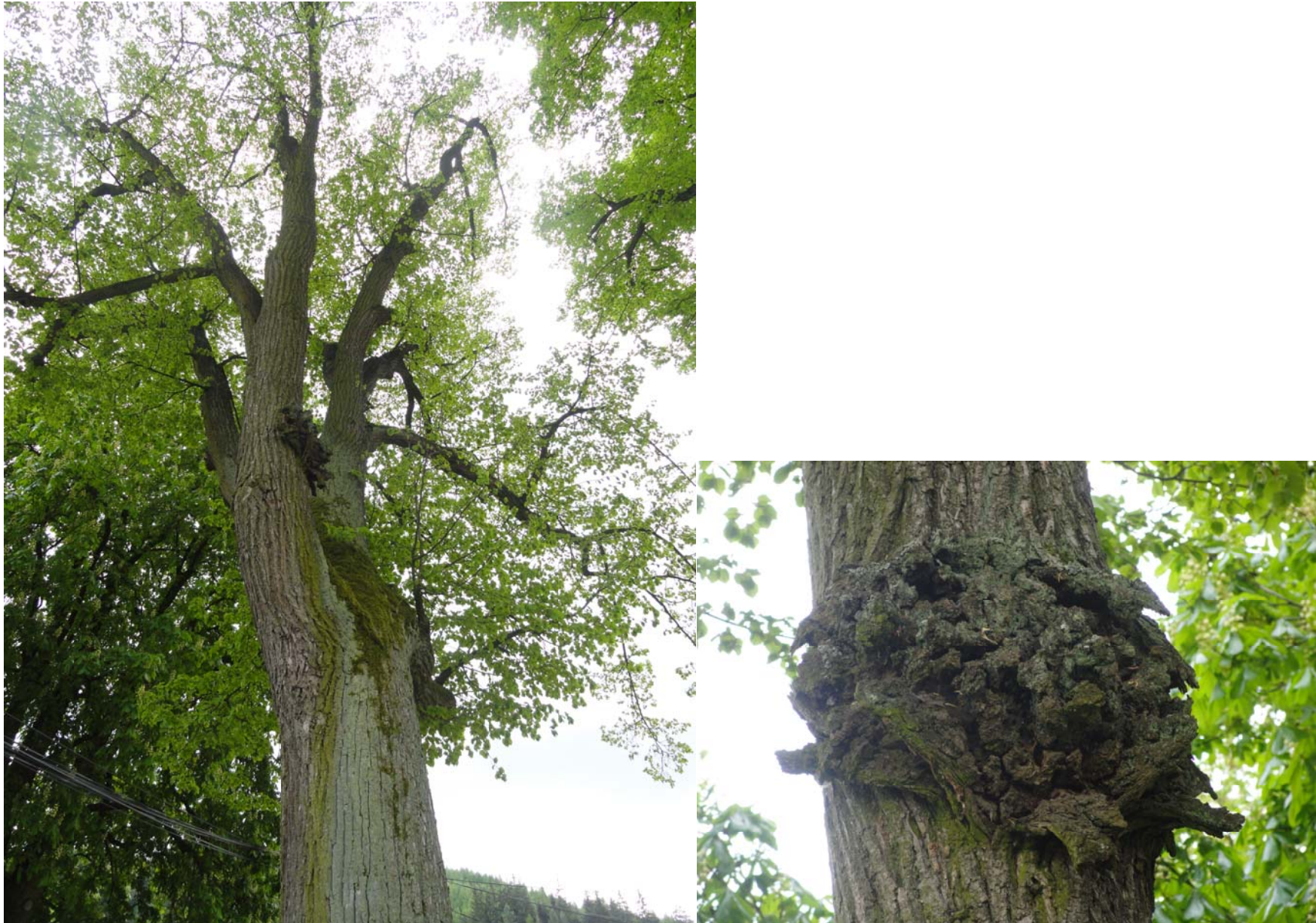
Strom č. 5. Detail větvení + defekt nad hlavním rozvětvením. V rámci ošetření nutno stromolezecky prověřit rozsah defektu a stav kosterních větví.
